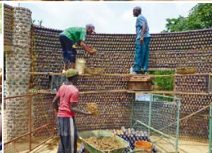
Kinder befüllten die Plastikflaschen zunächst mit Sand. Dann wurden die Flaschen durch Schnüre miteinander verbunden und wie Ziegelsteine vermauert. Fotos: Froese
