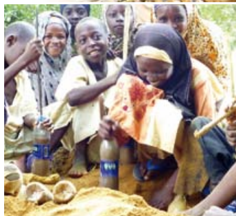
Kinder befüllten die Plastikflaschen zunächst mit Sand. Dann wurden die Flaschen durch Schnüre miteinander verbunden und wie Ziegelsteine vermauert. Fotos: Froese
