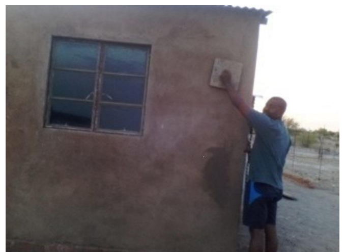
Bild: das Lagerhaus erhält den letzten Schliff
