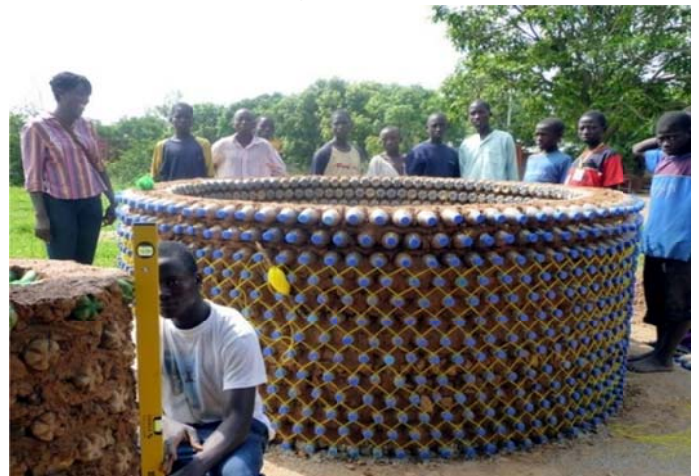
Bild: Wasserbehälter (noch unverputzt)
